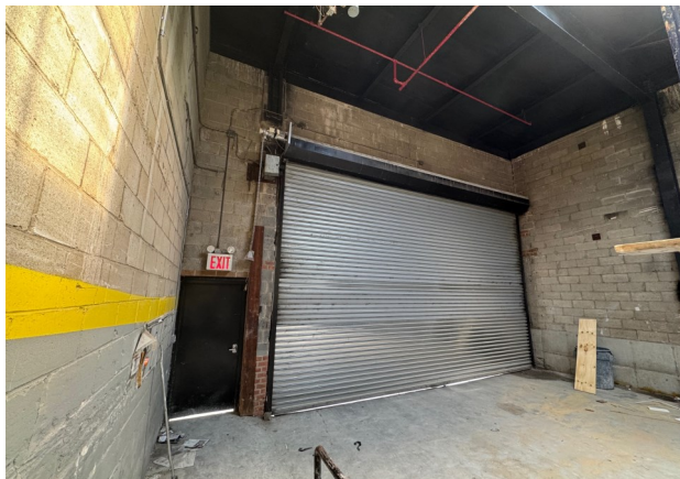
LOADING DOCK DOOR
